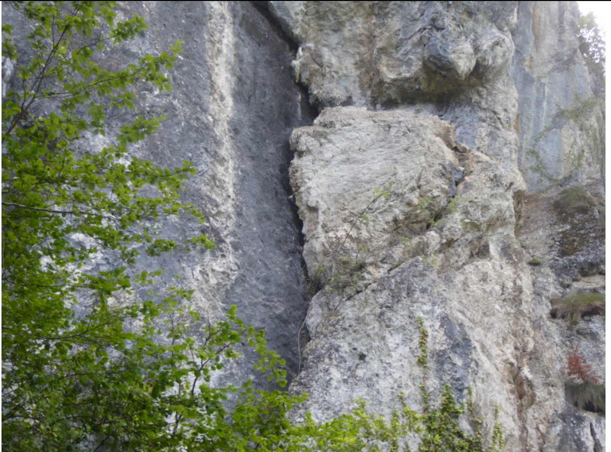
Dalle jaunâtre à inspecter
