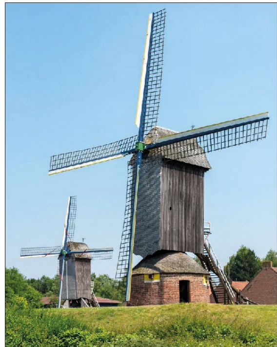
Fig. 10 : Exemple de moulin sur piédestal (à gauche) et sur pivot à base circulaire (à droite), Villeneuve d'Ascq
