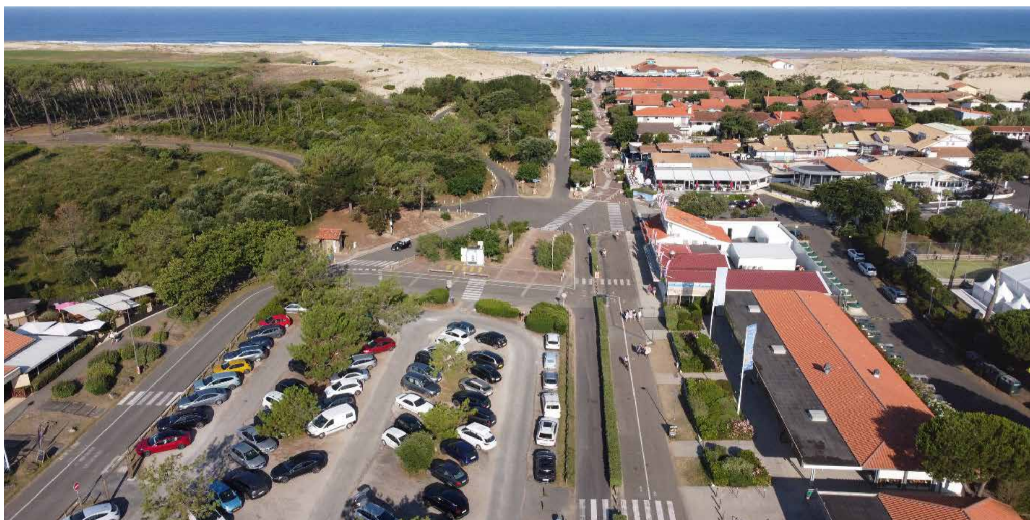
Top départ pour les travaux de réaménagement du cœur de Moliets !
