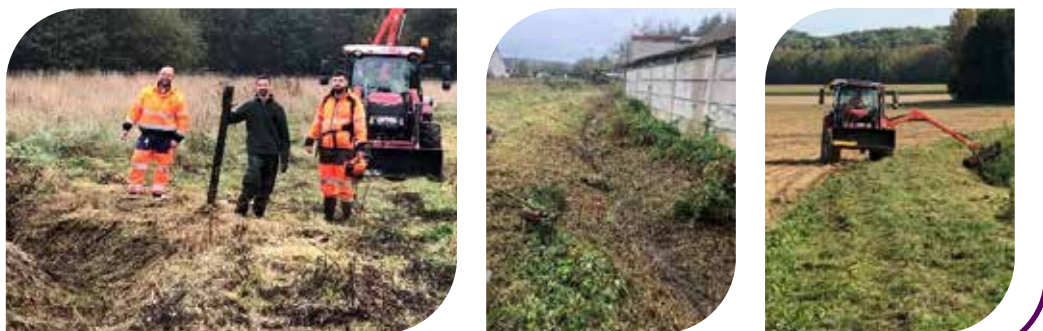
Curage et nettoyage de fossés
