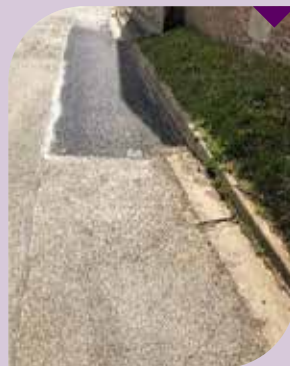
Diverses reprises bitume
