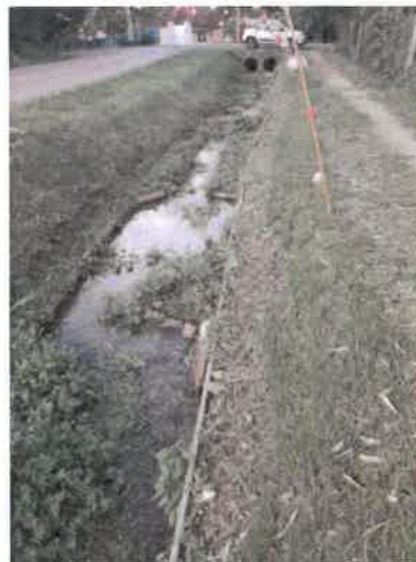
Vue des mêmes travaux 4 mois plus tard
