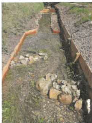
Juin 2022 - Travaux réalisés au Clos de Noé
