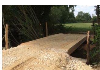
Exemple passerelle sans garde-corps
