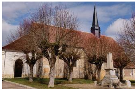
Réfection de la toiture de l'église
