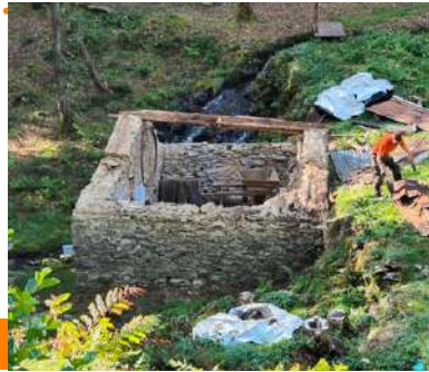
Travaux moulin de Chamalot
