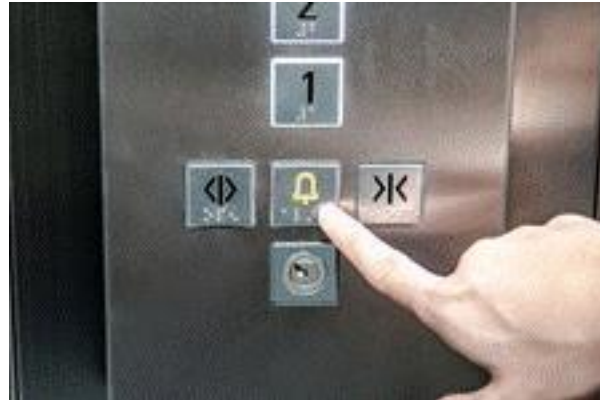
Les lignes de sécurité d'ascenseur
