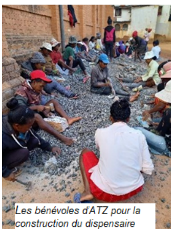
Le dispensaire en construction
