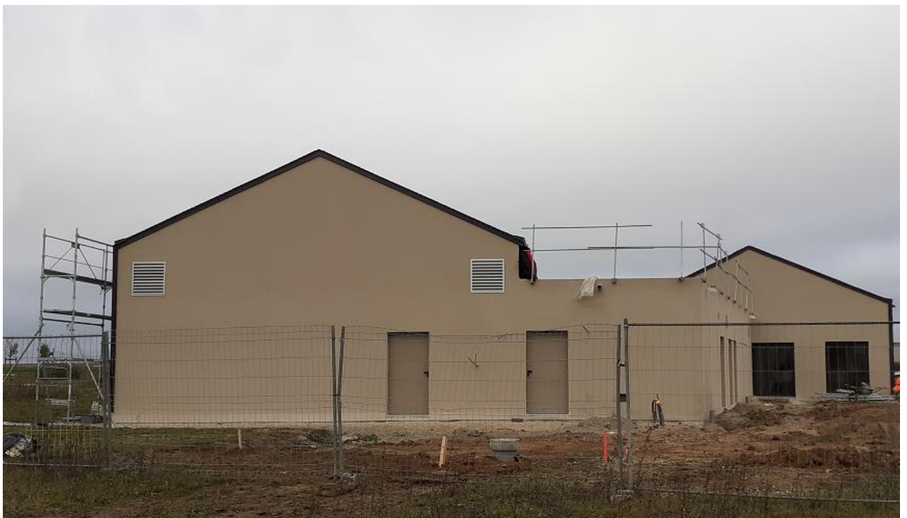
Ravalement arrière du bâtiment public
