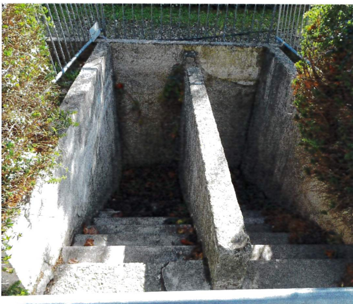
Anciennes toilettes à démolir.
