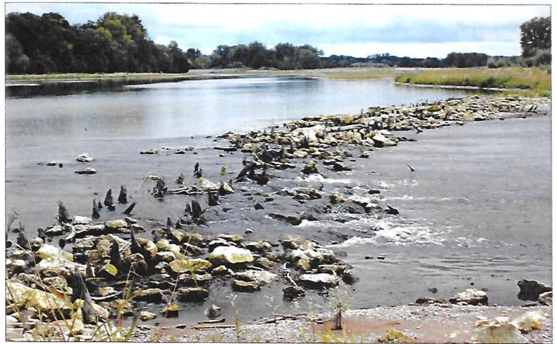
*Les pieux et les pierres constituant la digue de Pouilly-sur-Loire, en amont du pont routier, photographiés au cours de l'été 2011. Cf. P. Moyat.*
