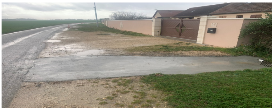
Aménagement en béton abords de 3 avaloirs Rue des Gouffiers Bigeonnette
