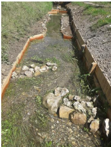
Juin 2022 - Travaux réalisés au Clos de Noé
