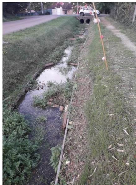
Vue des mêmes travaux 4 mois plus tard
