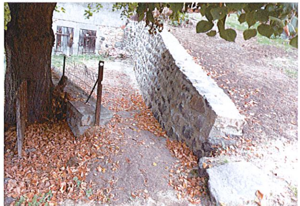
MUR DE SOUTENEMENT LE PONT DU VERNET (APRES)
