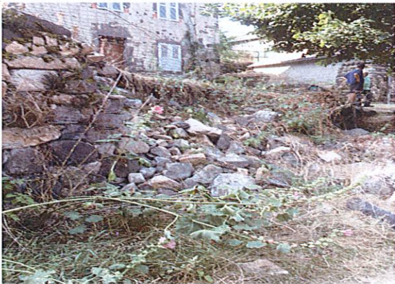
MUR DE SOUTENEMENT LE PONT DU VERNET (AVANT)
